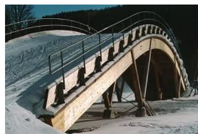
© Wiesner-Hager Baugruppe Ges.m.b.H.
