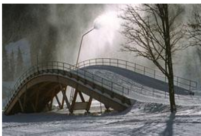
© Wiesner-Hager Baugruppe Ges.m.b.H.
