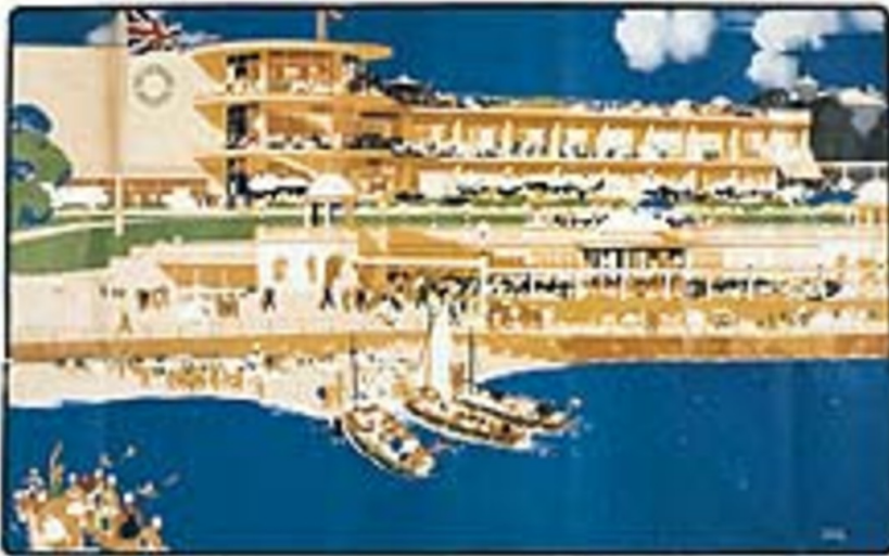
De La Warr Pavilion
