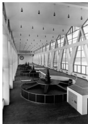
© Kraftwerk Birsfelden AG
