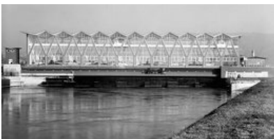
© Kraftwerk Birsfelden AG
