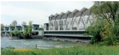
© Kraftwerk Birsfelden AG
