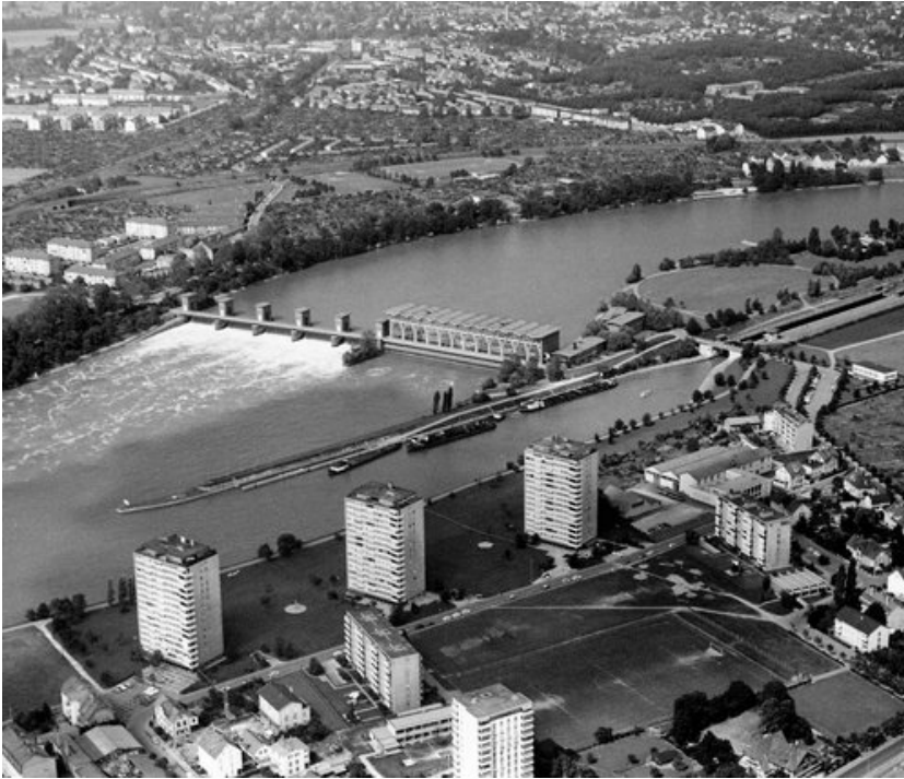
© Kraftwerk Birsfelden AG
