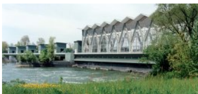
© Kraftwerk Birsfelden AG
