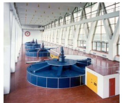
© Kraftwerk Birsfelden AG
