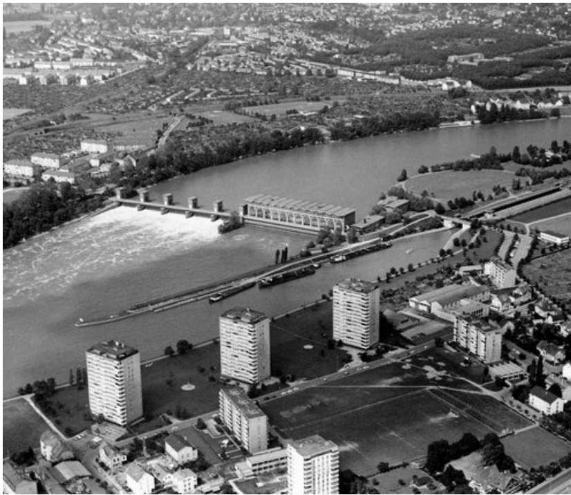
© Kraftwerk Birsfelden AG
