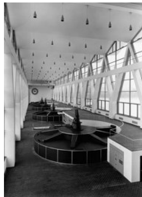
© Kraftwerk Birsfelden AG
