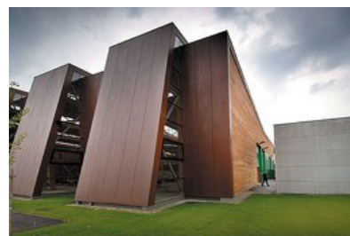
© Obermayr Holzkonstruktionen GesmbH
