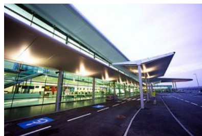
© Flughafen Graz Betriebs GmbH
