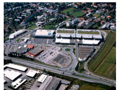
© ATP architekten ingenieure
