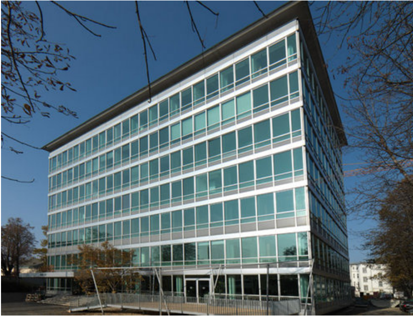
© Atelier Heiss Architekten
