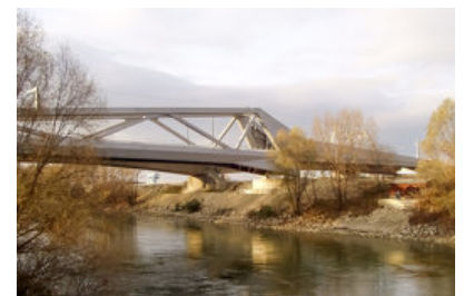
© Albert Wimmer ZT GmbH
