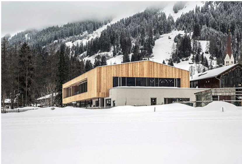
© ATP architekten ingenieure
