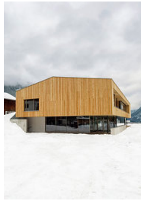
© ATP architekten ingenieure
