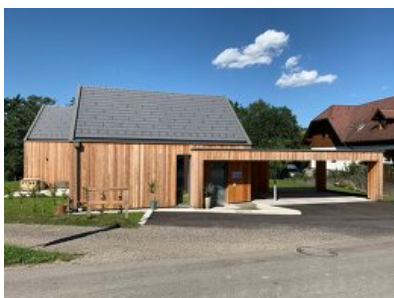
© Bauer Brandhofer Architekten
