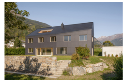
© Nadia Vontobel Architekten GmbH
