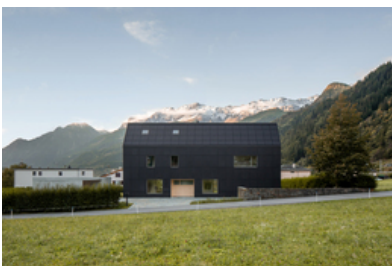
© Nadia Vontobel Architekten GmbH
